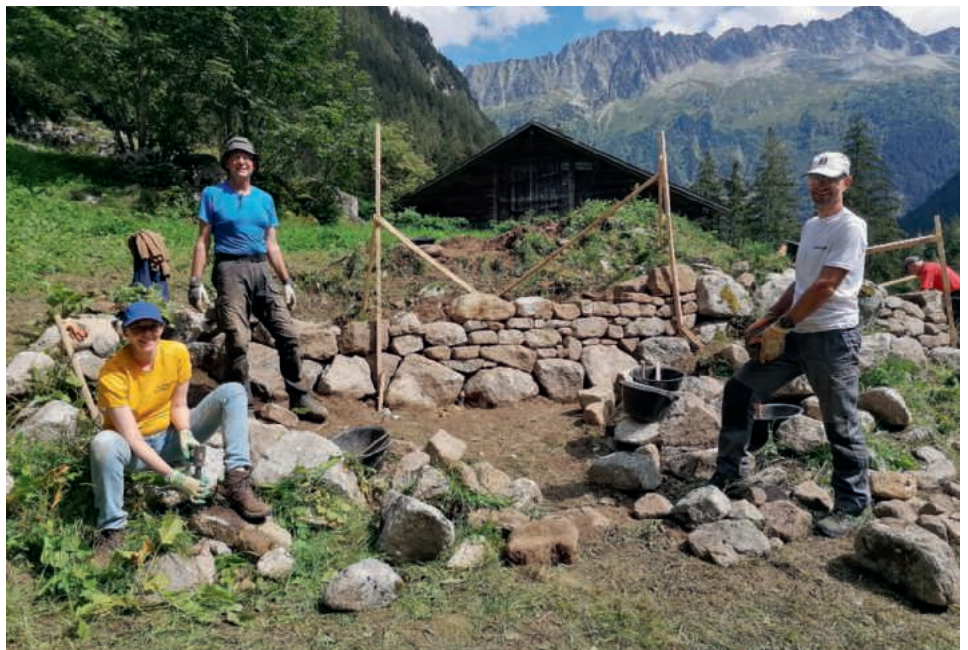
Photo du haut: épierrage et travaux d'entretien sur les prairies d'alpage de l'Alp Panära (SG). Photo du bas: réfection d'un mur de pierres sèches dans la vallée de Meien (UR).
